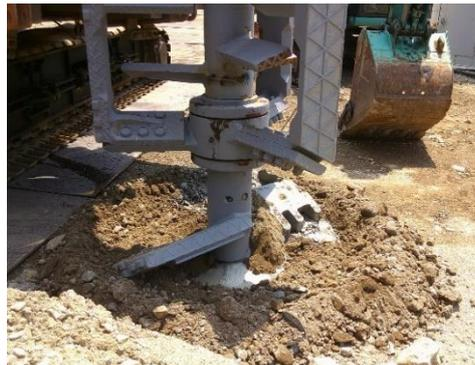
試験掘削 攪拌(掘削)径 1.6M
